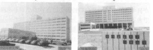
基礎臨床研究棟
