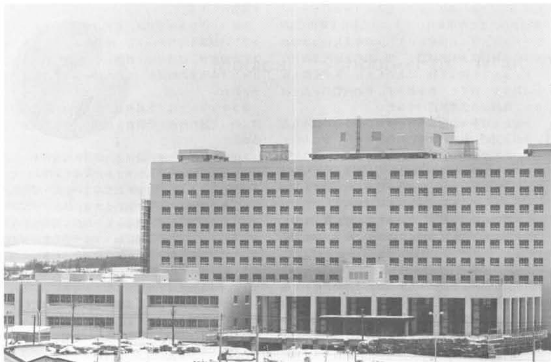
完成間近の本学附属病院
