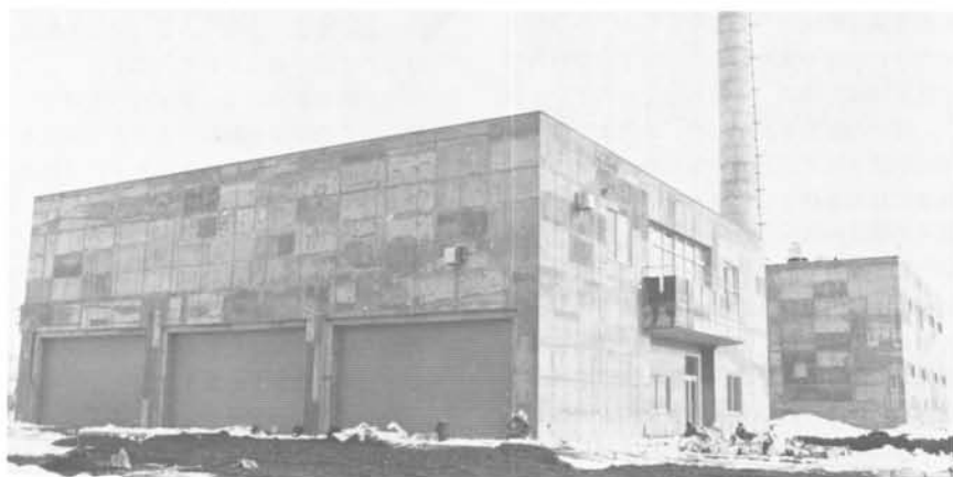
エネルギーセンター
