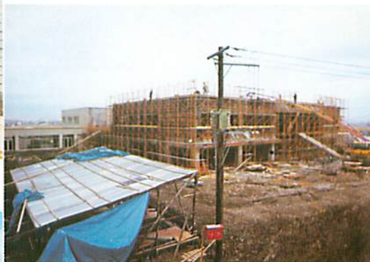
● 工事中の附属図書館
