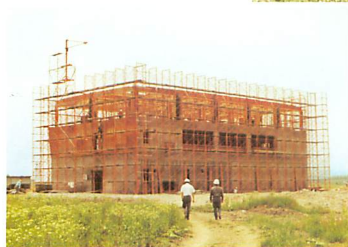
● 工事中の中央研究棟
