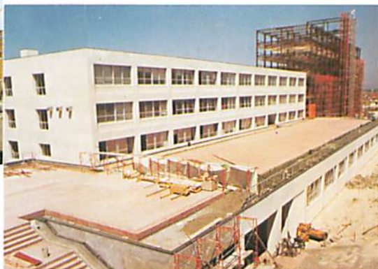
● 竣工した講義実習棟
