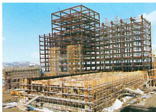
● 工事中の附属病院
