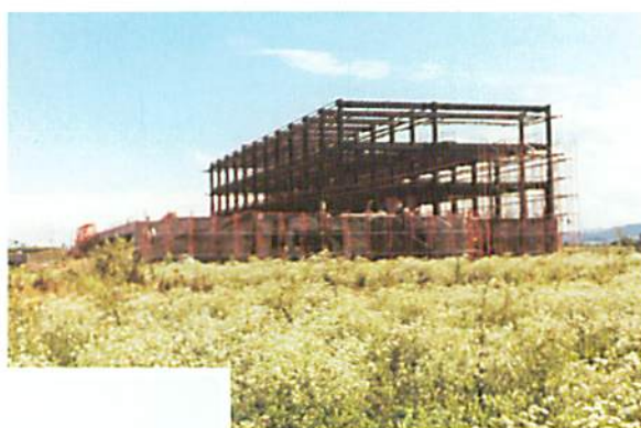
● 工事中の講義実習棟
