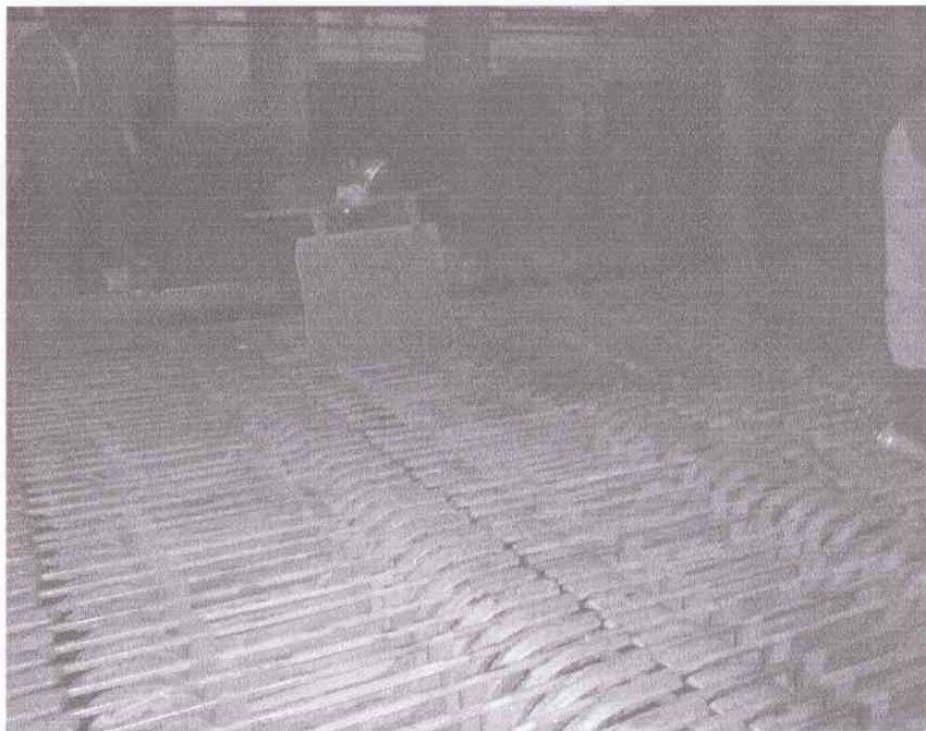
銅電気精錬槽
