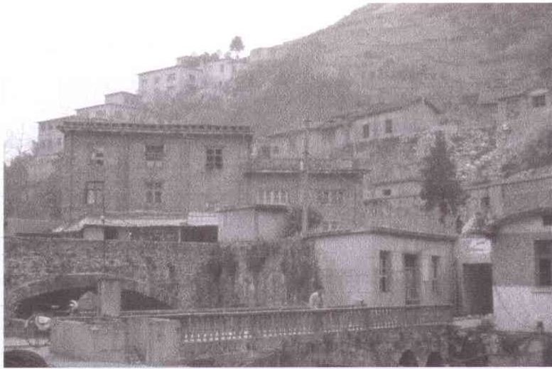
雄黄鉍地上建屋全景
