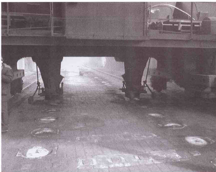
コークス炉 炉頂・石炭車石炭投入ノズル
